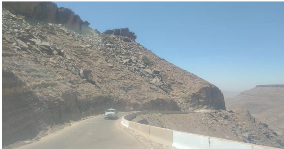
Photo 8 : Paysage rocheux entre Chinguitty et Atar traversé par le tracé de la FO
