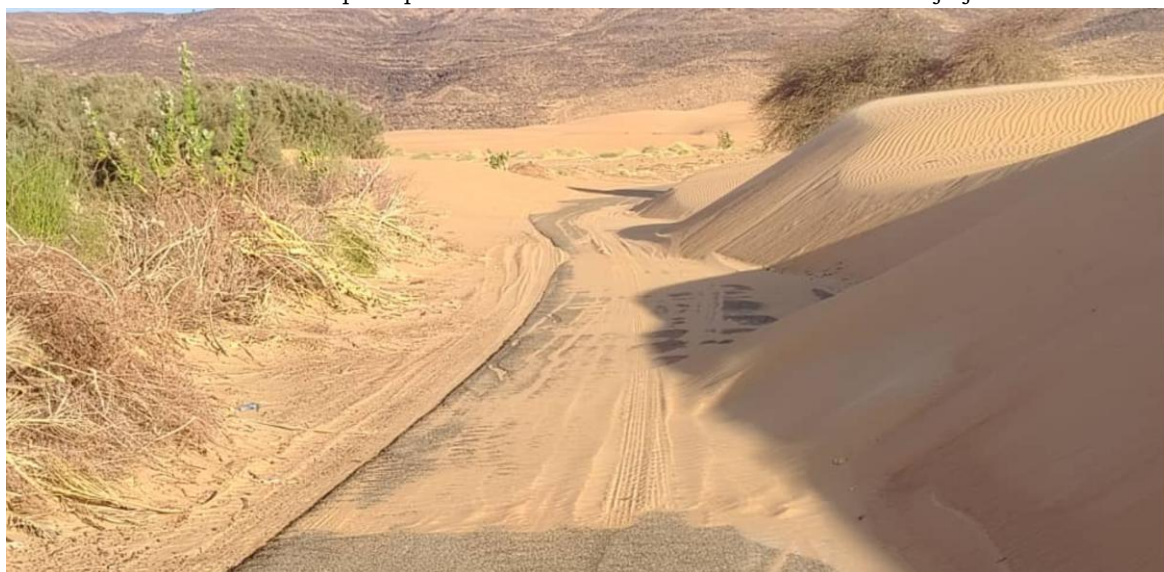
Photo 5 : Dunes de sable occupant partiellement la chaussée entre Rachid et Tidjikja
