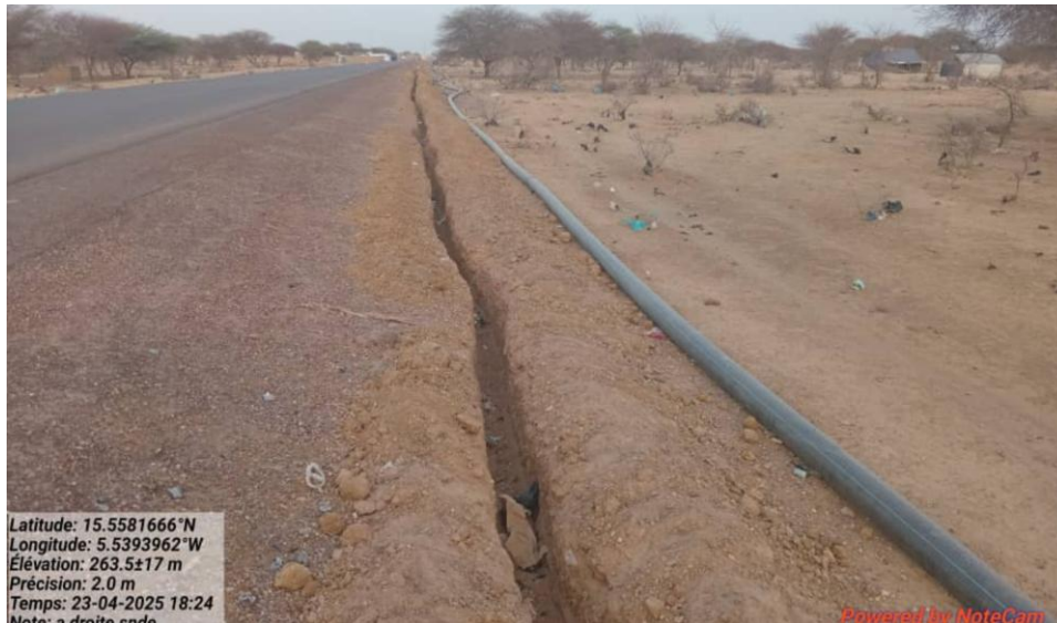
Photo 3 : Route bitumée à l'entrée de Fassala, réseau SNDE en cours de creusement, longée par le tracé de la FO
