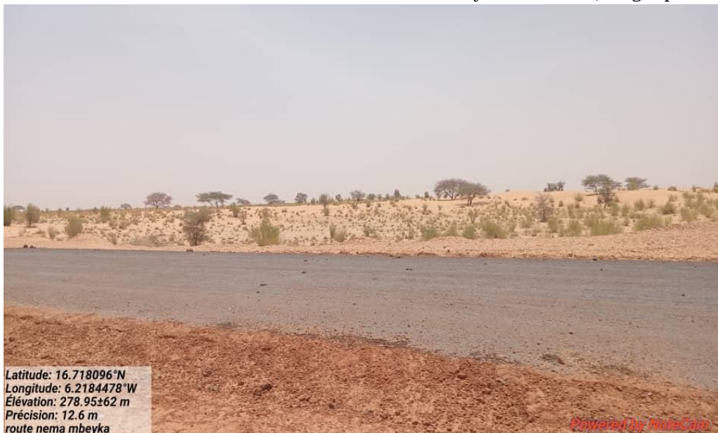
Photo 4 : Route en cours de construction entre Achemine et Mbeykite Lahwach, longée par le FO
