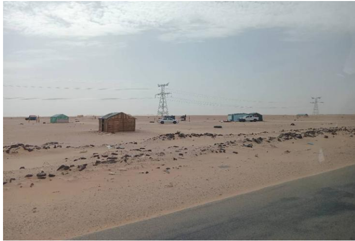
Photo 1 : Pylône entre Nktt-NDB ou seront installés les câbles de FO
