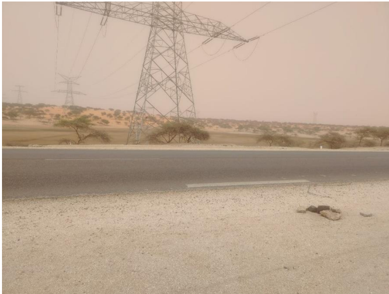
Photo 4 : Partie de le RN2 empiétée par le tracé entre Nktt-Rosso à la rentrée de Tiguint
