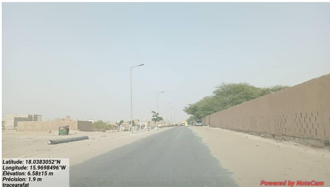
Photo 3 : Voirie urbaine de Ryad ( côté cimetières de PK ) longée par les câbles de FO
